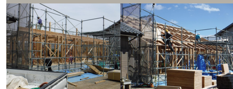
建物の骨組みが決まる上棟は、自社の仕事のみを行う大工が組み上げていきます。
